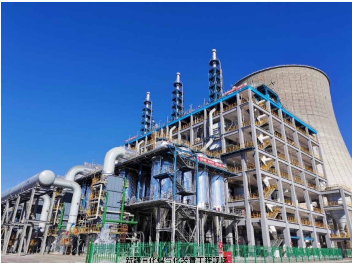
新疆宜化煤气化装置工程现场
