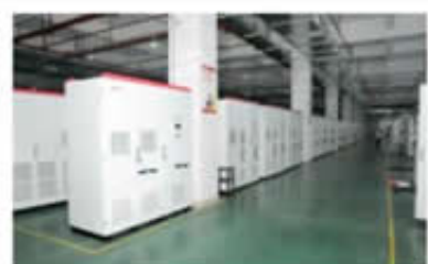
新能源光伏总装车间
